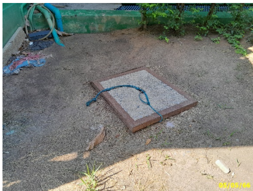
บ่อพักน้ำสุดท้ายก่อนระบายออก กทม.
