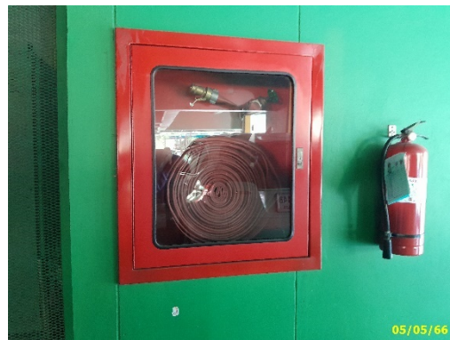
ตู้เก็บสายฉีดน้ำ และถังดับเพลิงแบบมือถือ
