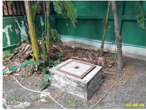
บ่อบำบัดน้ำสุดท้ายก่อนระบายออกคลองสาธารณะ
